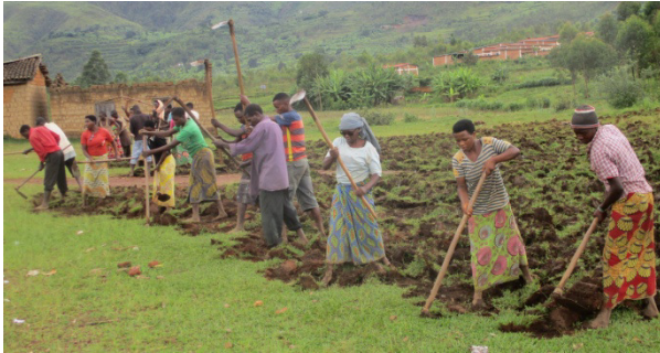
Wie alles andere geschieht auch das Einebnen der Fläche in Handarbeit.
